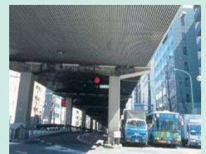
แผ่นเก็บเสียงใต้ผนังสำหรับทางลอด
