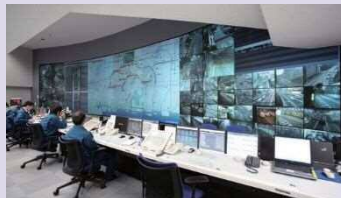
ห้องควบคุมการจราจร
