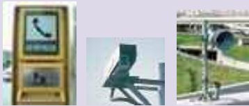
โทรศัพท์จุดเงิน กล้อง CCTV ตัวตรวจจับยานพาหนะ
