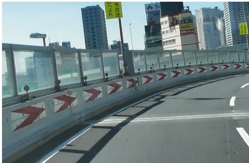
都心環状線（外）浜崎橋JCT分流
