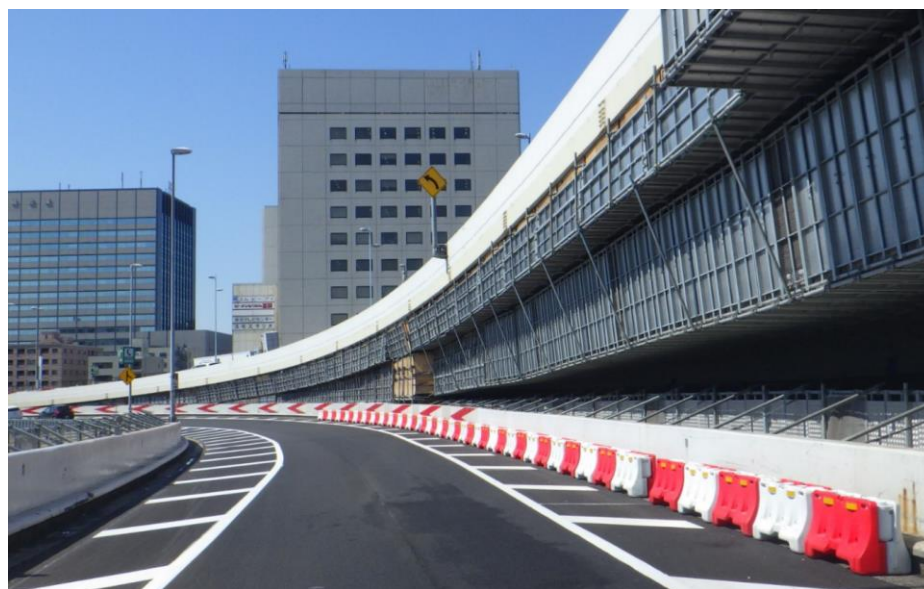
6号向島線（上）両国JCT（バリケード型ブロック）
