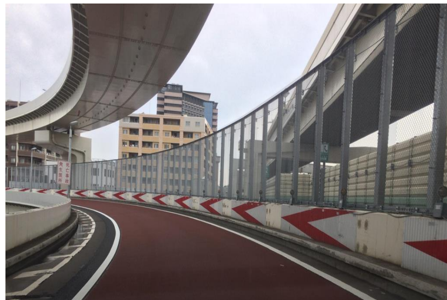
3号狩場線（上）阪東橋出口
