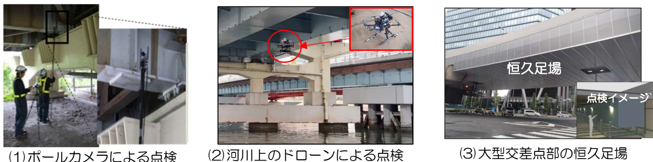
図 6.1 点検実施状況
