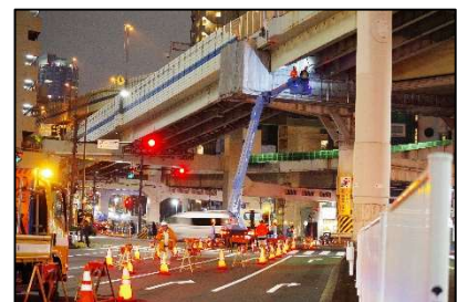
■ 定期点検（接近点検）
