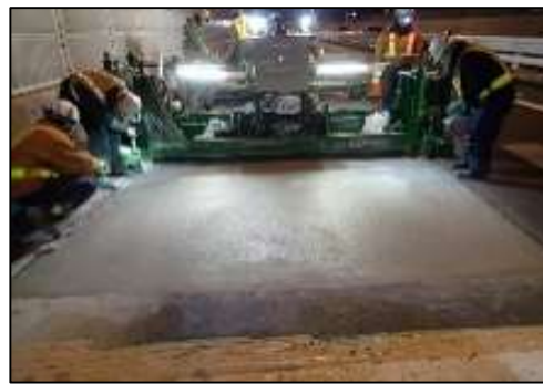
(2) コンクリート床版上面の増厚（PCM 舗装）
