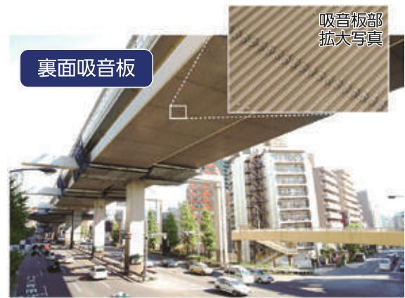
裏面吸音板設置事例(高速3号渋谷線:目黒区大橋付近)
