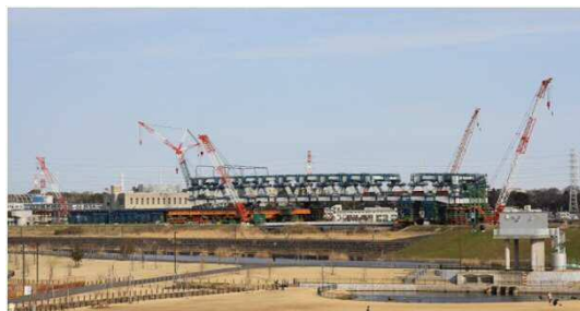
写真① 鶴見川沿い (送り出し架設工)
