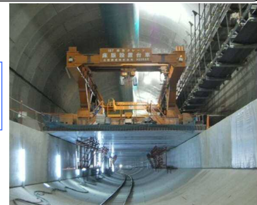
写真② 本線シールド内 (シールド掘進工、床版工)
