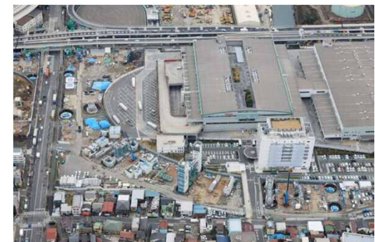
写真④ 生麦JCT (高架橋の橋脚架設工)
