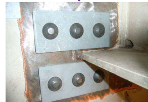
鋼桁き裂補強
