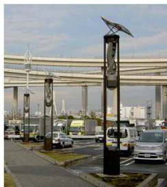
高速湾岸線 大黒PA 太陽光＋風力照明灯
