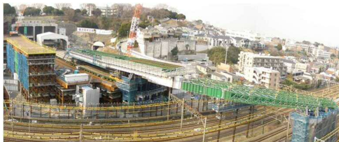
写真③ 生麦JCT (鉄道交差部) (送り出し架設工)
