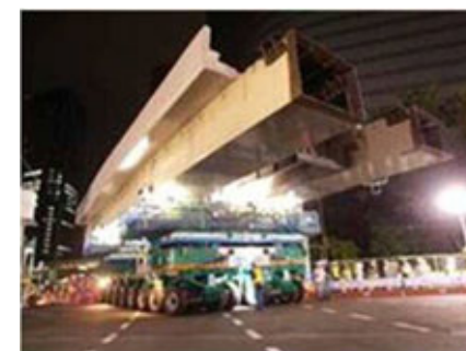
多軸台車による橋桁の運搬(撤去時)
