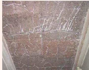
き裂の進展を抑制するため応急補修を実施済
