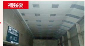
コンクリート床版の下面に炭素繊維シートを格子状に接着することで、ひび割れの開閉が拘束され、コンクリート床版の耐久性が向上します。
