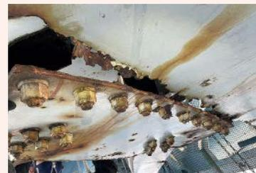
ガセットプレートの破断(2021年)
