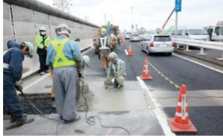
土木構造物(伸縮継手)の補修
