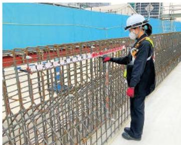
中央分離帯コンクリートの配筋検査状況
