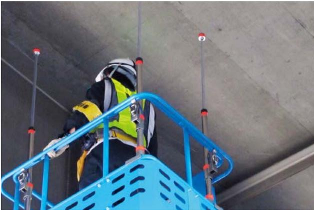
橋梁における床版・桁の点検作業
