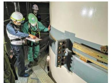
鋼製橋脚接合部の溶接前検査状況
