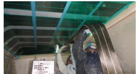
土木構造物（コンクリート床版）の補強
