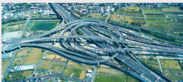
横浜北西線 横浜青葉JCT
