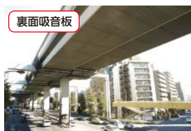
裏面吸音板設置事例 (高速3号渋谷線:日黒区大橋付近)
