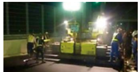
舗装工事実施状況
