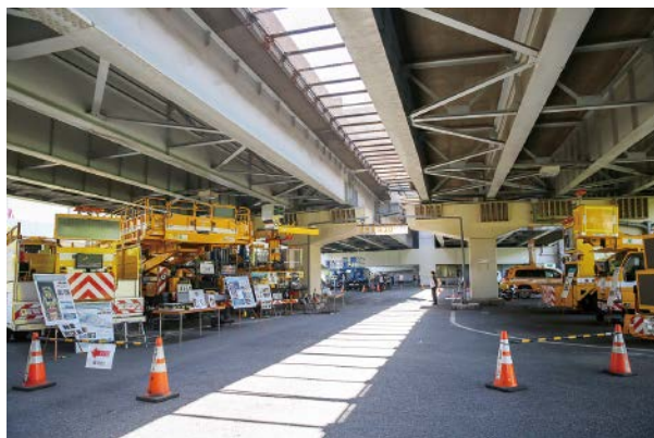
「点検・補修デモ2019」の様子
