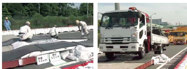
地震時の緊急交通路確保（訓練の様子）
