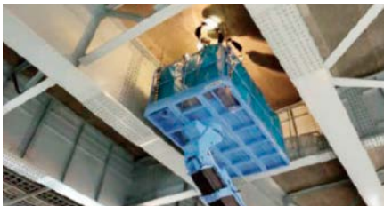
橋梁の接近点検
