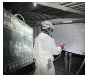
塗装作業の様子
