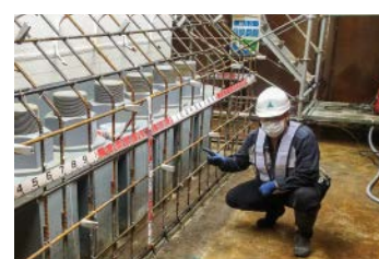
橋脚基部コンクリートの配筋検査状況
