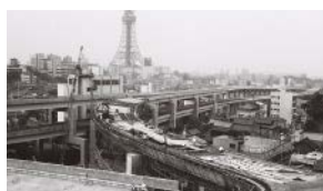
建設中の一ノ橋 JCT
