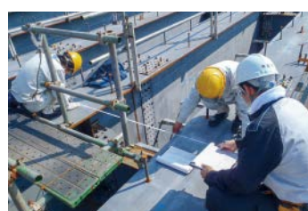
鋼上部工構造物仮組立てにおける寸法確認
