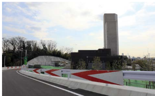
当社の建築施設(神奈川7号横浜北線 馬場換気所)
