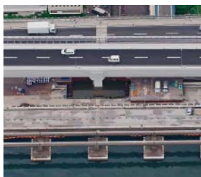
大規模更新工事の様子
