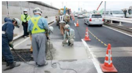
土木構造物（伸縮継手）の補修
