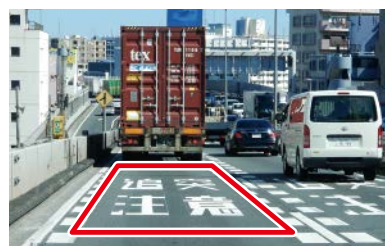
路面文字・追突事故対策 (6号向島線(下り)新大橋カーブ手前)
