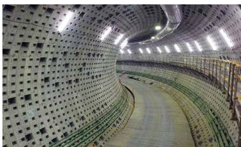
急勾配・急曲線の大断面シールドトンネル
