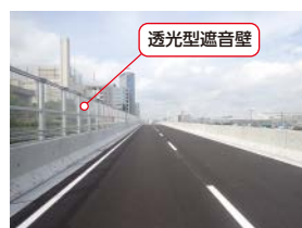
遮音壁・裏面吸音板の設置
