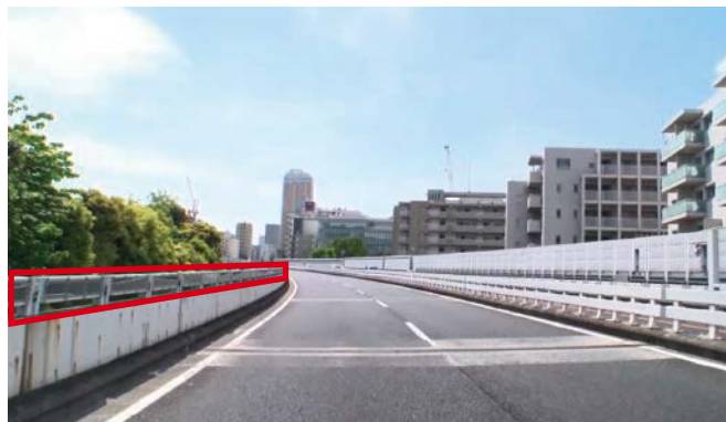
高欄照明(2号目黒線)
