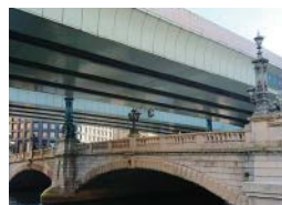
竹橋・江戸橋JCT付近(日本橋区間)
