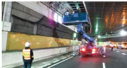
トンネルの接近点検
