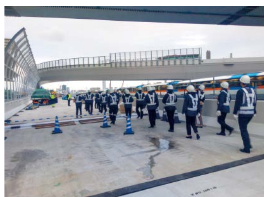
東品川橋・鮎洲埋立部現場視察会
