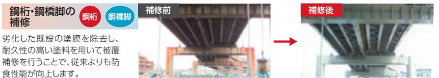
劣化した既設の塗膜を除去し、耐久性の高い塗料を用いて被覆補修を行うことで、従来よりも防食性能が向上します。
