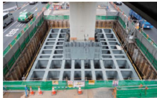
鋼製格子部材による合成構造フーチング
