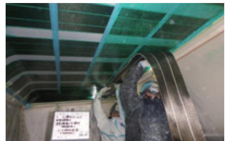
土木構造物（コンクリート床版）の補強
