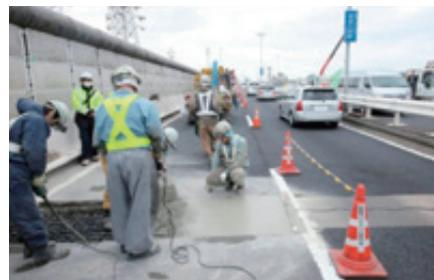
土木構造物（伸縮継手）の補修
