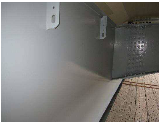
【仕上がり状況（スプレー塗装）】
