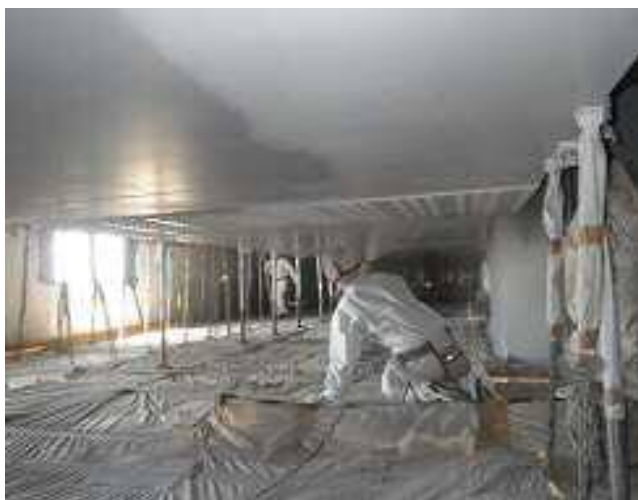
【水性塗料のスプレー塗装状況】
