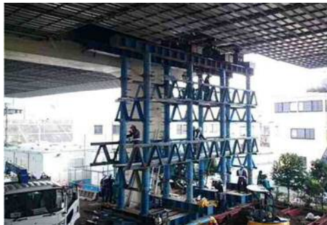
写真-1 仮支柱設置状況
