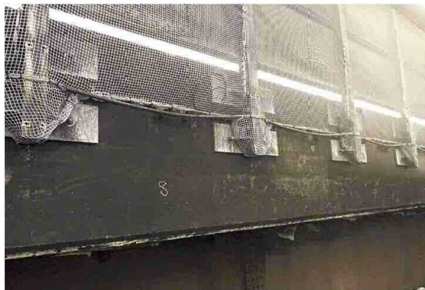
写真-6 遮音壁（落下防止ネット設置後）
