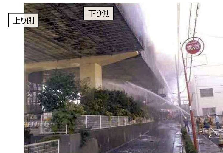
写真-1 消防による放水状況
