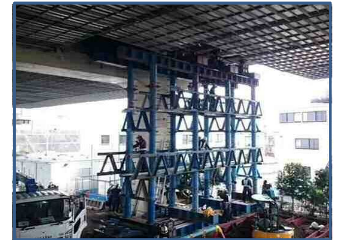
写真-13 仮支柱状況（1）
