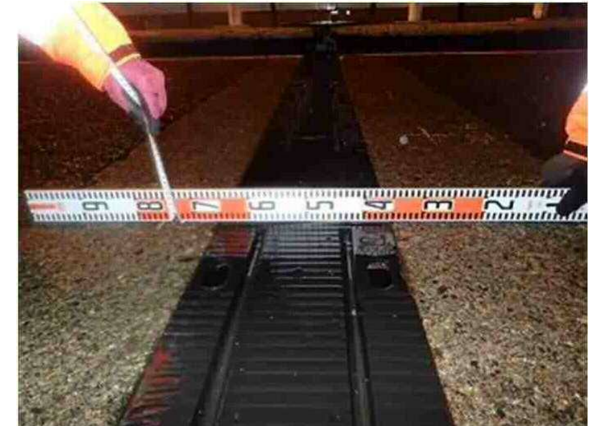
写真-5 伸縮継手
