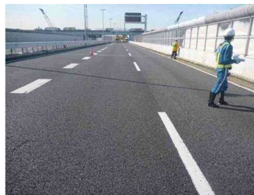
写真-4 高速上(下り)損傷なし
