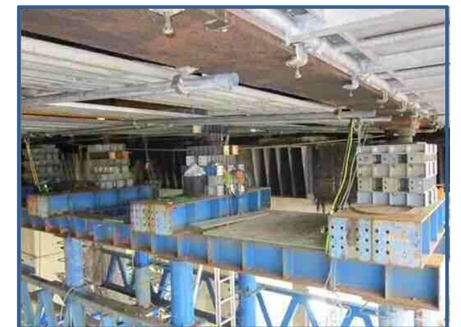
写真-14 仮支柱状況（2）
