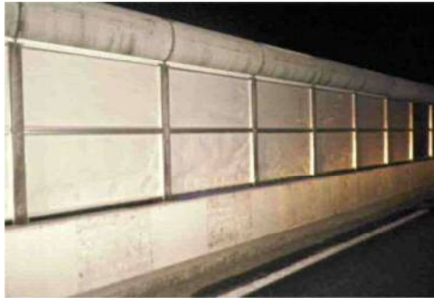
写真-2 透光板飛散防止テープ貼付
