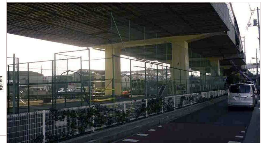
写真-3 高架下の状況
