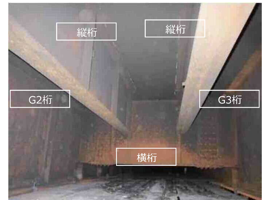
写真-9 下り線健全部の状況
