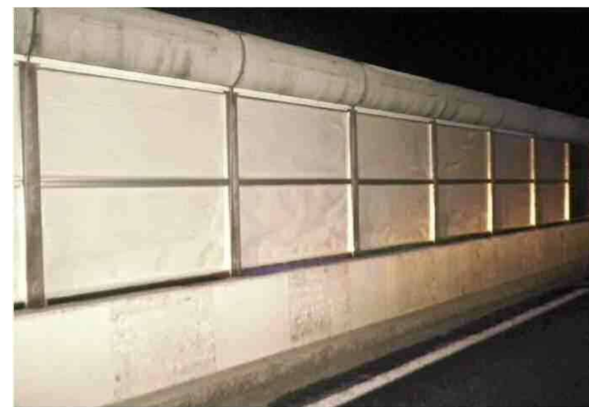
写真-7 遮音壁（透光板飛散防止テープ貼付後）
