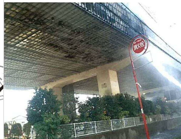
写真-1 消防による放水状況
