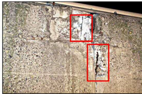
コンクリート剥離・鉄筋腐食
