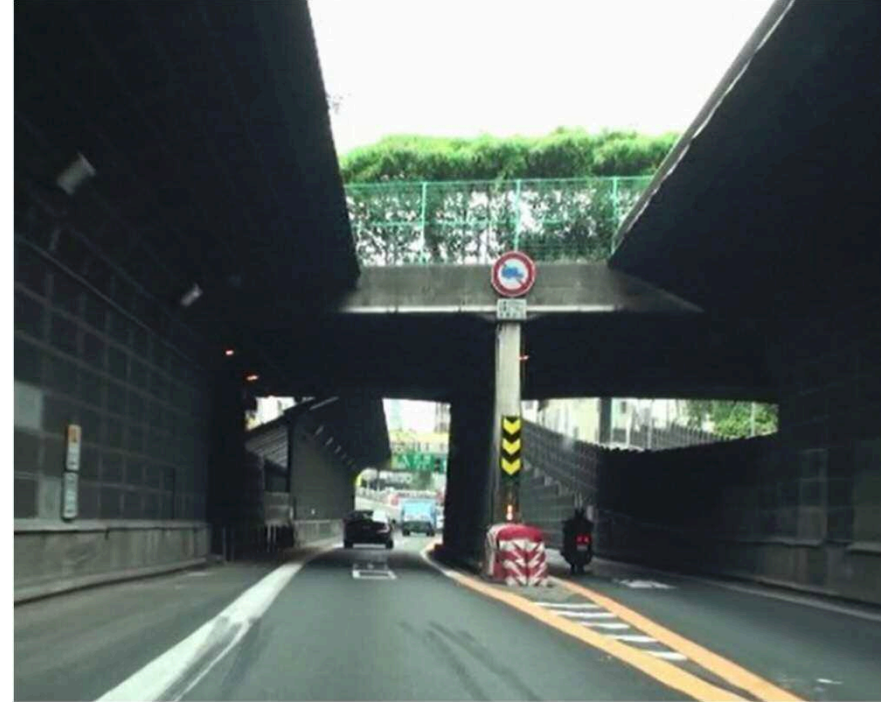
車道内橋脚の事例
