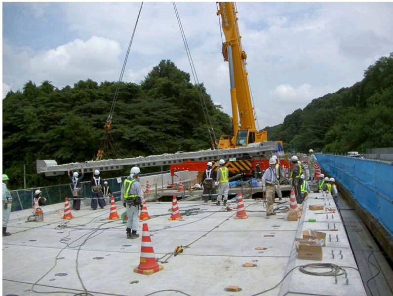
工場製作床版活用の事例
