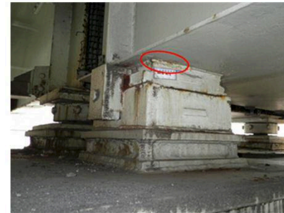
【支承部の疲労き裂】
