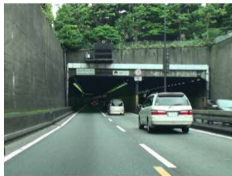
北の丸トンネル坑口付近 (経過年数47年)
