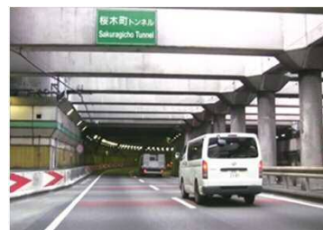
桜木町トンネル坑口付近 (経過年数34年)
