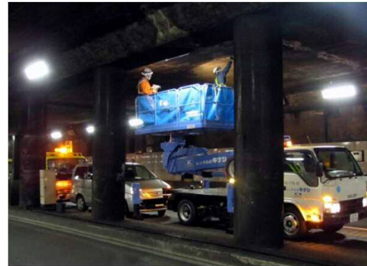
接近点検 (霞が関トンネル)
