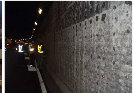
側壁コンクリート部の状況 (霞が関トンネル)
