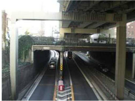
■ 脚、側壁が車線を分断している状況
