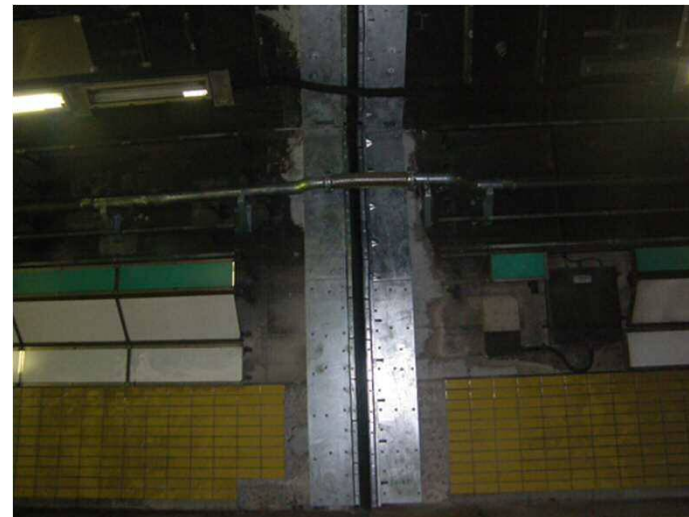
継手部の止水板補強 (桜木町トンネル)
