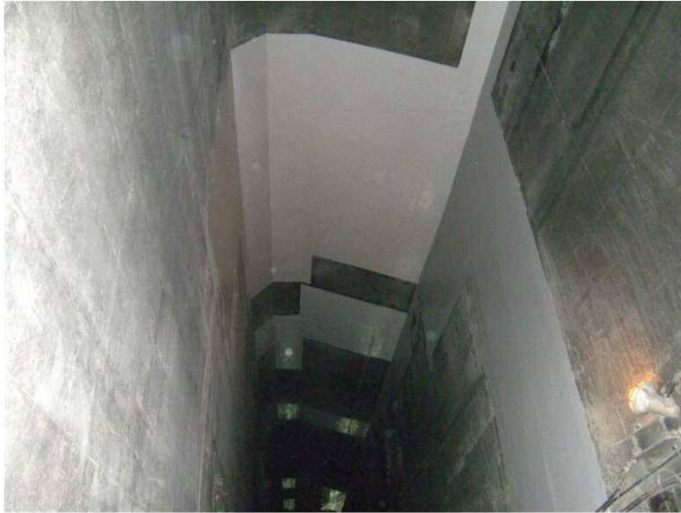
ダクト部の頂版-側壁部 断面補修 (東京港トンネル)
