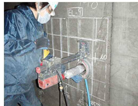
ダクト部側壁 試験コア採取状況
