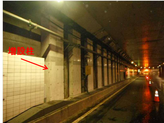
側壁柱部の耐震補強 (赤坂トンネル)
