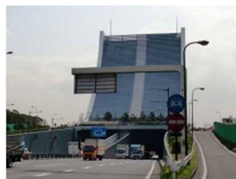
東京港トンネル坑口付近 (経過年数35年)
