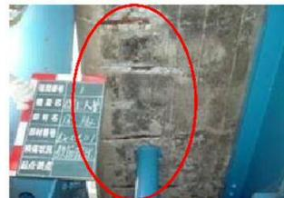
床版のコンクリートの剥離・鉄筋露出
