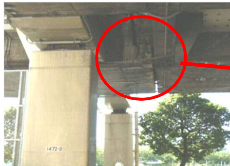
PC切欠桁部のひびわれ(ゲルバー構造)
