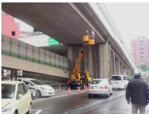
高所作業車を使用した点検
