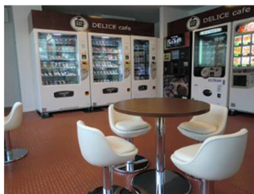
休憩室内の改修状況 （南池袋 PA）
