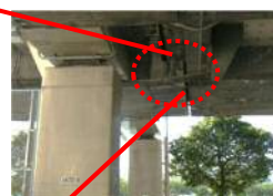
PC 桁ゲルバー部のひび割れ
