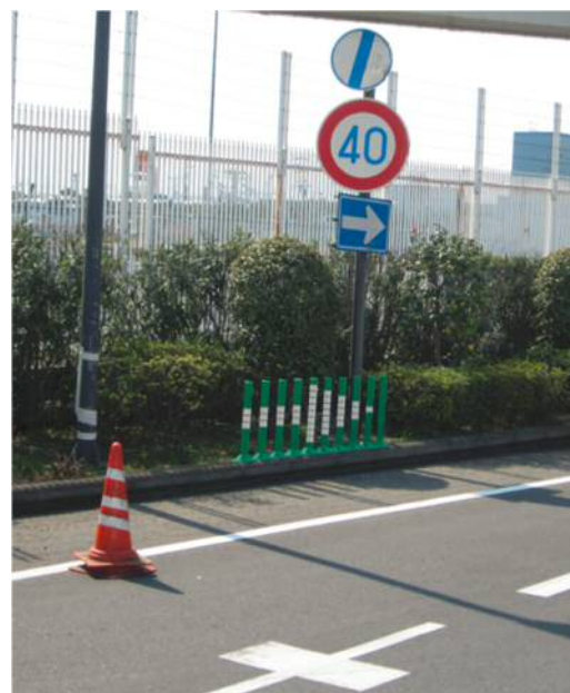
ラバーポール設置状況
