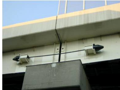
支承・連結装置耐震補強（連結装置の設置）
