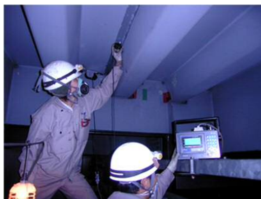
鋼構造物の溶接部における超音波探傷試験
