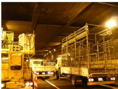
天井板撤去中状況
