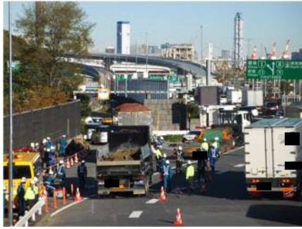
【実施状況（大井本線料金所）】
