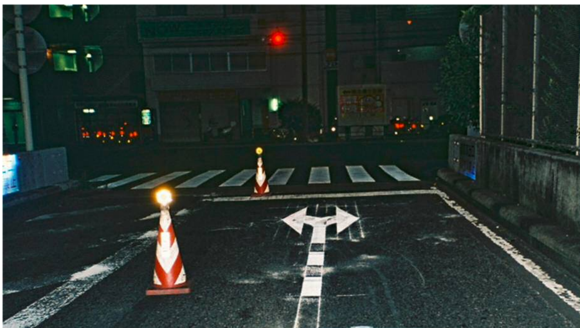
逆走防止路面矢印 設置状況 (6号向島線[下り]向島出口街路接続部)
