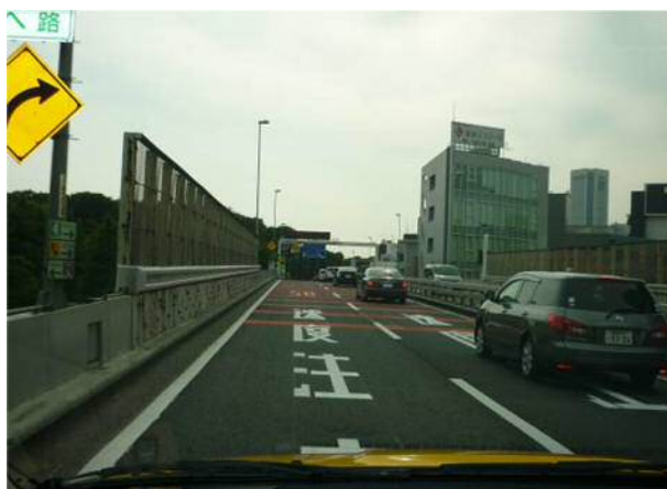
【注意喚起カラー舗装】
