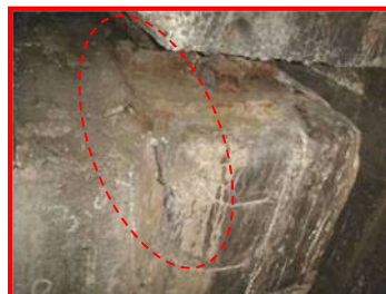
PC 桁ゲルバー部のひび割れ
