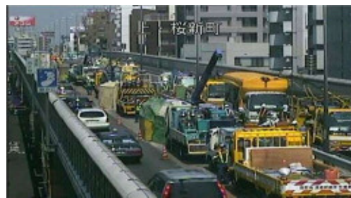
集中工事形式による施工
