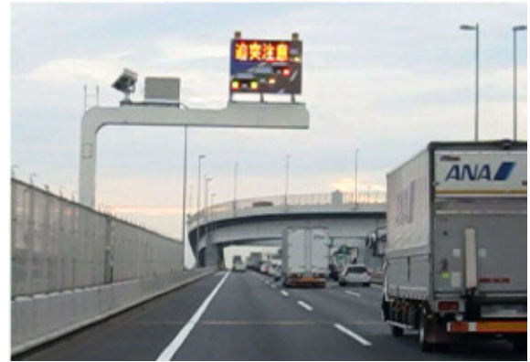
【LED 追突注意喚起板：葛西 JCT 分流付近】
