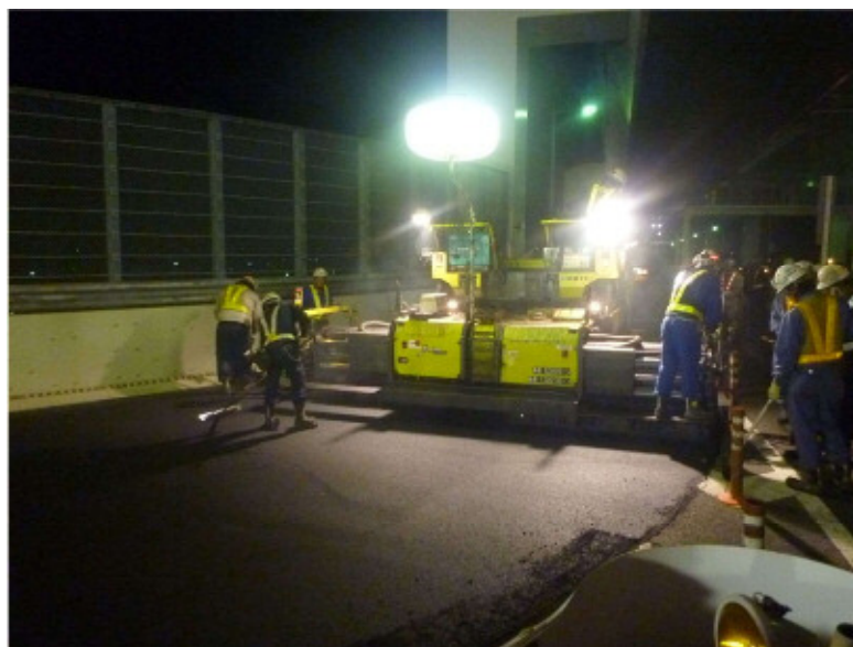
【舗装工事実施状況】
