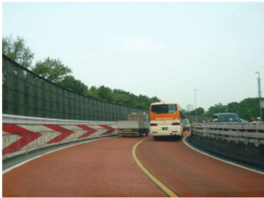
【注意喚起カラー舗装：赤坂 S カーブ】
