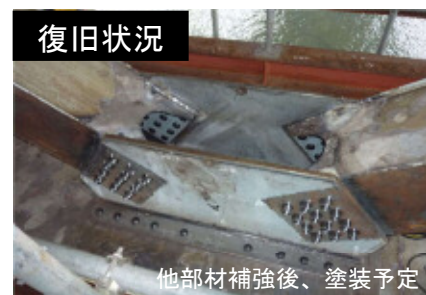
取付部材取替
