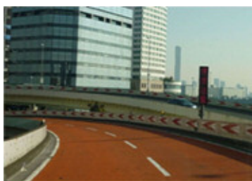
【注意喚起カラー舗装】
