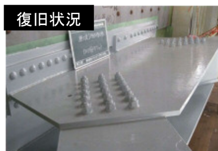
取付部材取替
