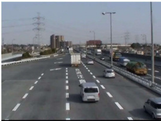
【車両整流化：川口本線料金所】
