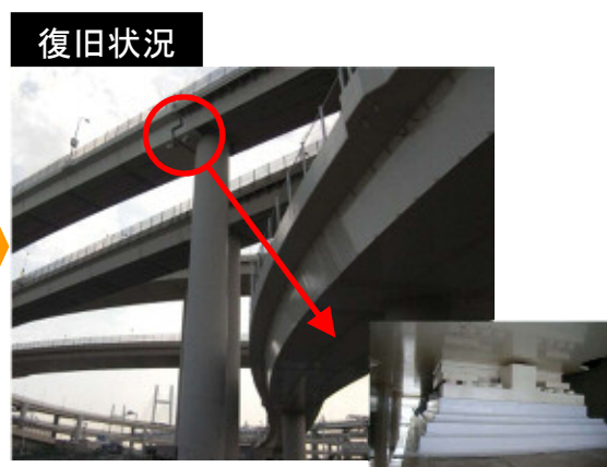
橋桁・支承の取替
