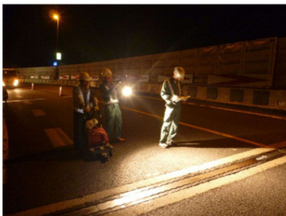
【高速道路上徒歩点検 （1号羽田線羽田入口付近） 平成23年7月実施】
