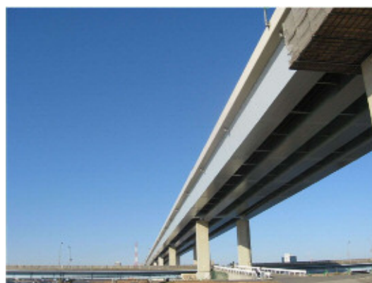
(施工後) 鋼桁・橋脚の塗装
