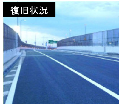
段差修正、ジョイント・舗装補修
