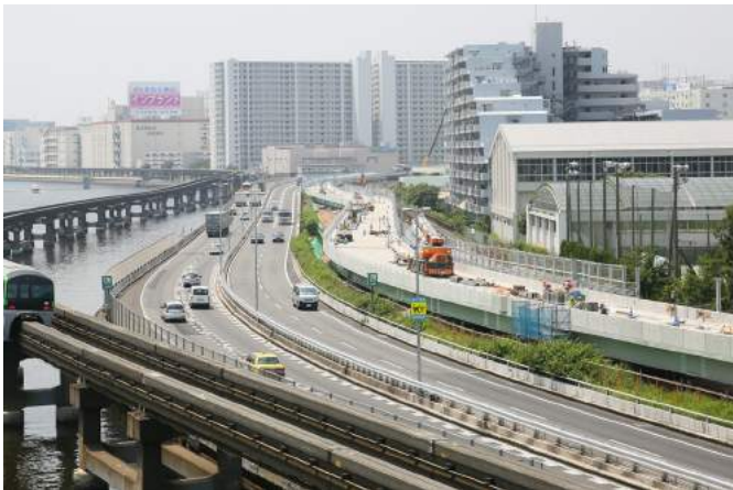
Detour construction status (June 2017)
