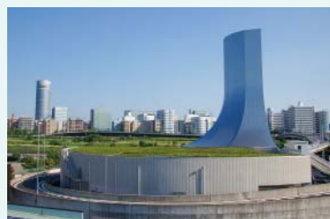
新横浜換気所
