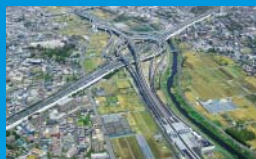
従来の環境への取り組みを着実に実施するとともに、環境マネジメントを推進し、脱炭素社会の実現に向けた取り組みを計画的に実施
