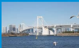
ネットワーク拡大とともに、長大橋の意匠デザイン、高架橋の美装化など、都市景観の向上
