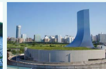
新横浜換気所
