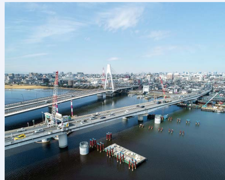
高速大師橋施工状況(2021年2月)
