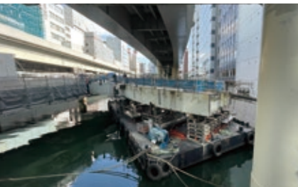
呉服橋出入口 撤去中
