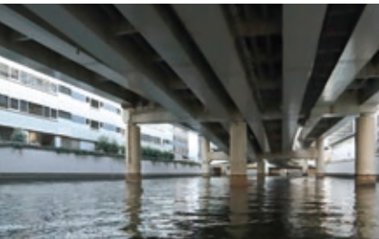
呉服橋出入口 撤去前
