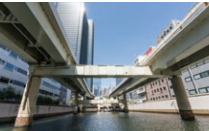
呉服橋出入口 撤去後
