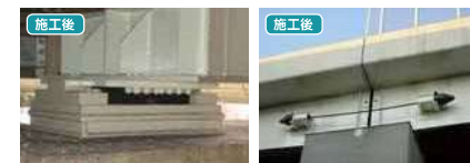
耐震支承への交換
