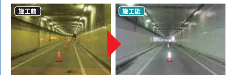
繊維シートによる補修工事
