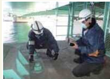
橋脚上の現地調査
