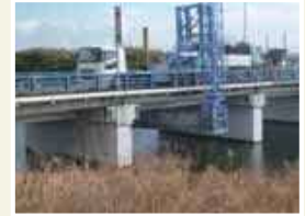
大型橋梁点検車による点検(国道6号)
