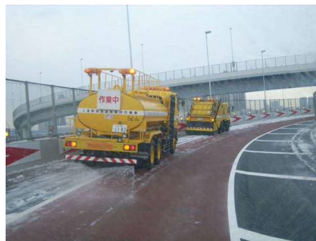
凍結防止剤(塩水)の散布状況
