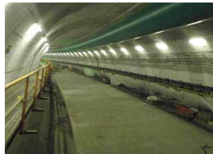
写真① 本線シールド床版の施工状況
