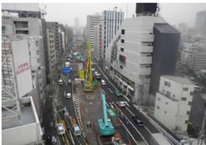
写真② 五反田出入口部の施工状況
