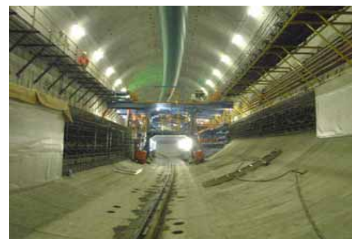
写真① 本線シールドの施工状況
