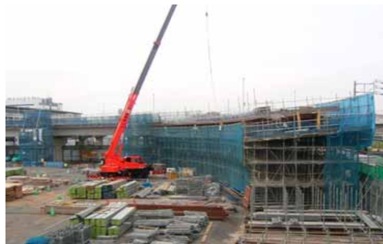
写真③ 生麦入口部施工状況
