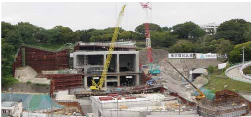
写真② 子安台換気所部施工状況
