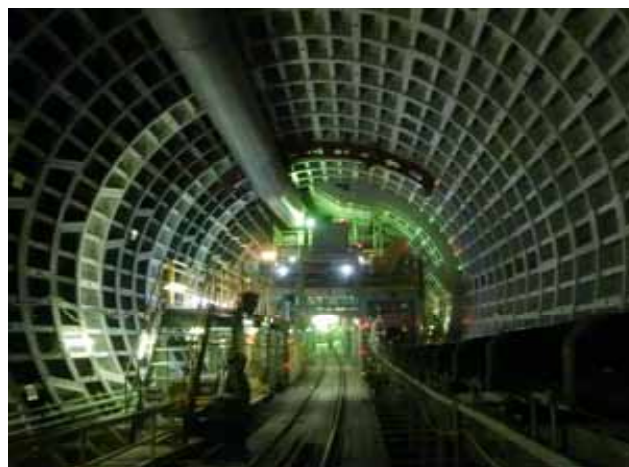
写真③ 大橋連結路シールドの施工状況
