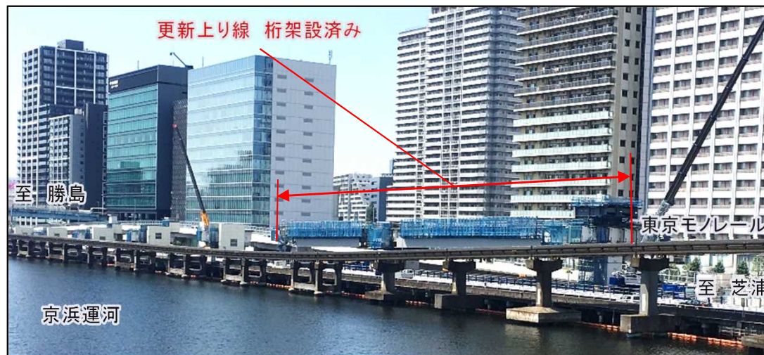
写真② 東品川栈橋部(桁架設状況)
