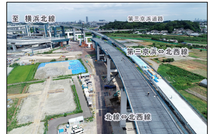
写真③ 横浜港北JCT部(桁架設状況)
