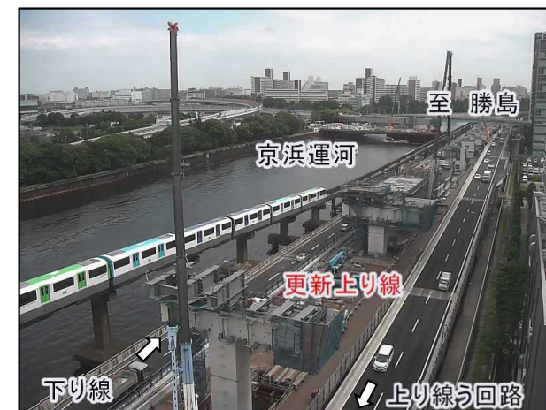
写真③ 東品川栈橋部(橋脚工)
