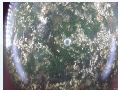
水中の映像 (鋼製橋脚防錆板の表面)
