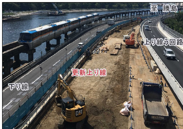
写真① 鮫洲埋立部(掘削工)
