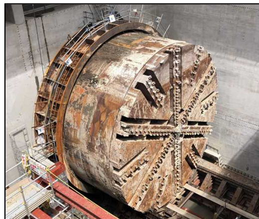
写真② シールドトンネル到達立坑
