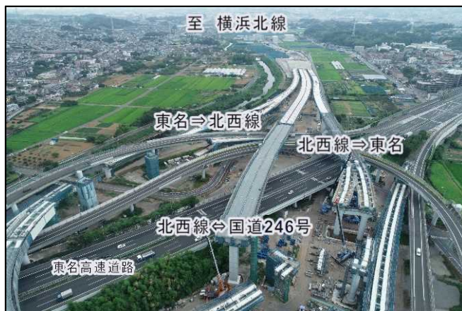
写真① 横浜青葉JCT部(桁架設状況)
