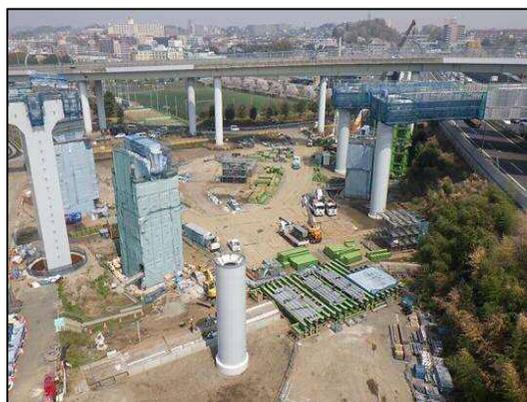
写真① 横浜青葉JCT部(橋脚架設状況)
