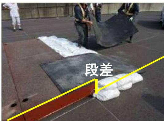
発泡系ガラス素材を土のう袋に封入（約5kg/袋、（通常土のうは約25kg））
