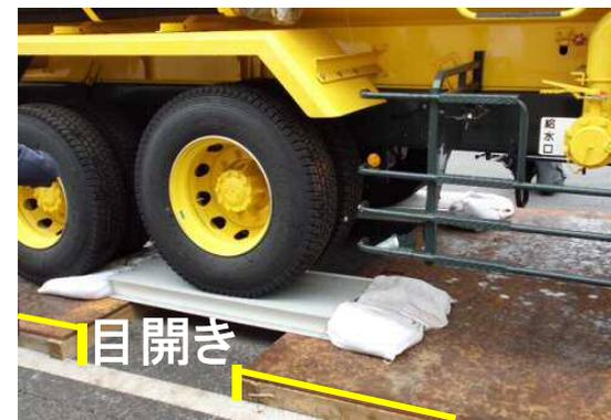
FRP(繊維強化プラスチック)製のパネルを組み上げた渡し材
