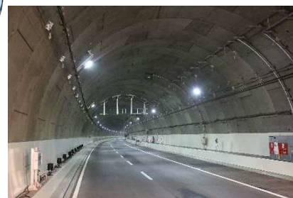
写真① 本線トンネル内装工
