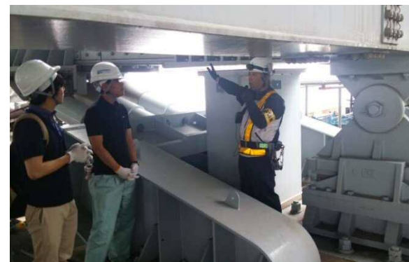
橋梁の維持管理技術に関する勉強会 (湾岸線新木場高架下)
