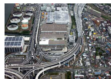
写真② 高架橋 舗装工
