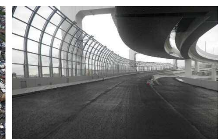
写真③ 高架橋 遮音壁工
