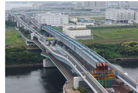
写真① 東雲運河部 桁架設工
