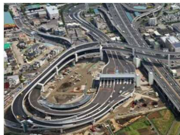
写真② 横浜港北JCT (高架橋の橋面工)
