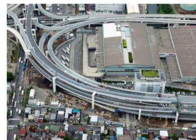
写真⑤ 生麦JCT (高架橋の橋面工)
