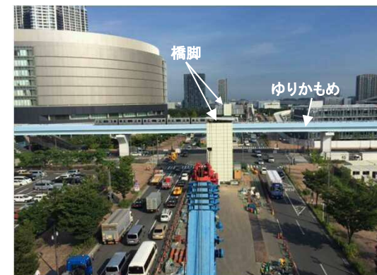
写真② 豊洲地区 橋脚架設工
