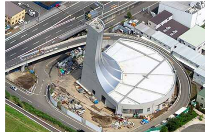
写真③ 新横浜換気所 (換気所躯体工)
