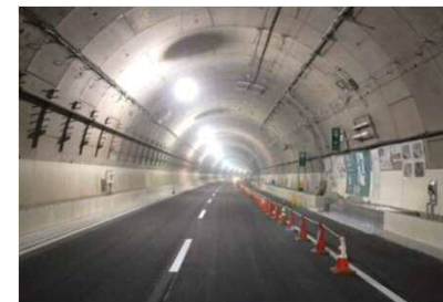
写真④ トンネル内装工
