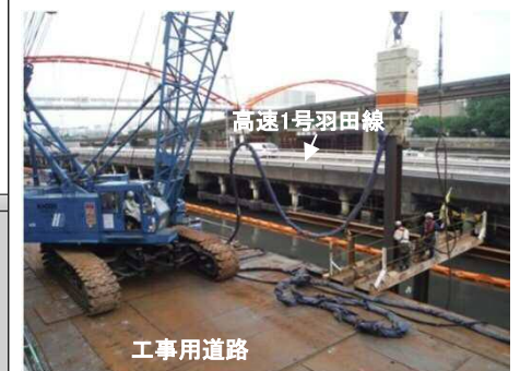
写真② 工事用道路工
