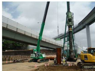
写真① 青葉側高架部 (下部工)
