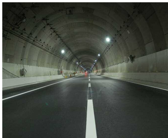
写真④ 横浜北トンネル
