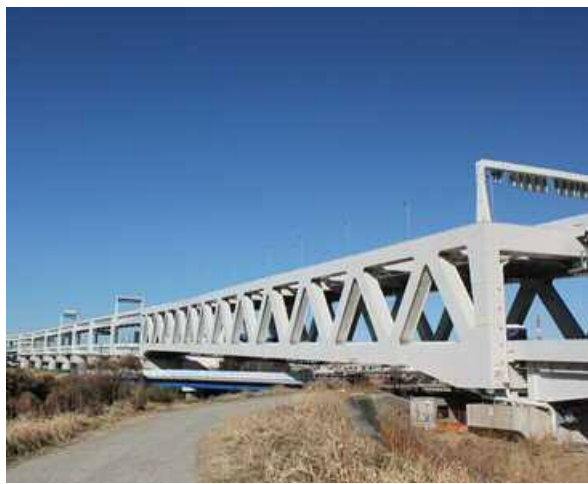
写真② 大熊川トラス橋
