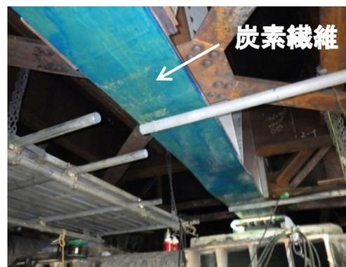
写真:2 下フランジの補強状況
