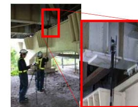
ポールカメラによる点検状況
