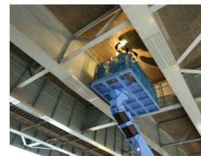
高所作業車による点検状況
