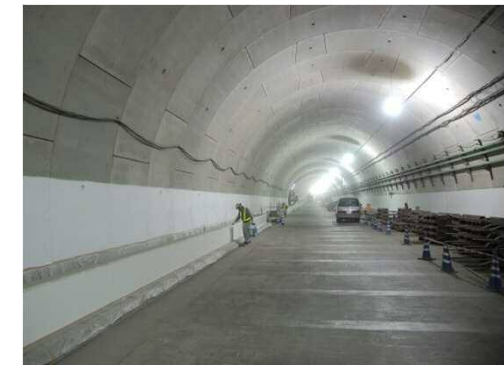
写真③ シールド内装工
