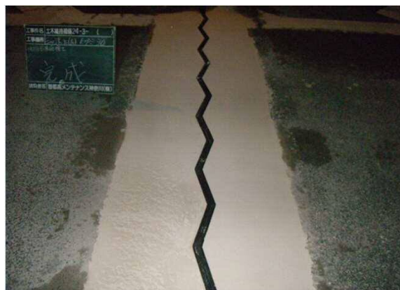
伸縮継手取替
