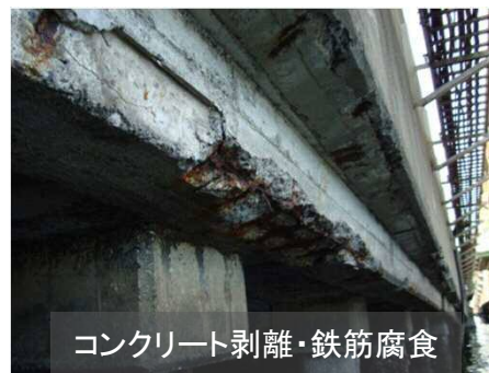
主桁の損傷
