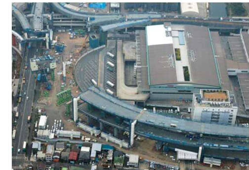
写真④ 生麦JCT (上部桁架設工)
