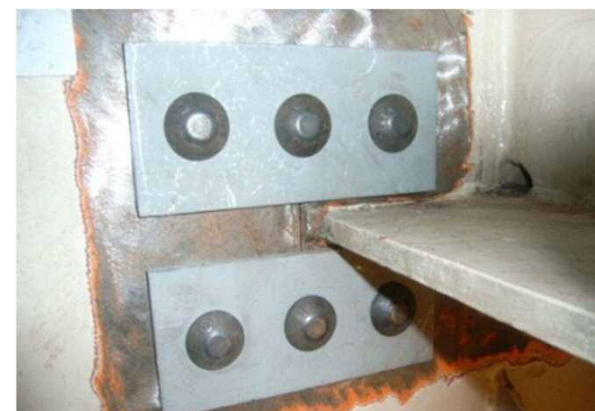
鋼桁き裂補強
