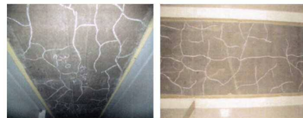
コンクリート床版の亀甲状ひび割れ
