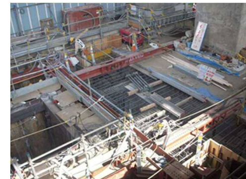
写真① 基礎工事状況
