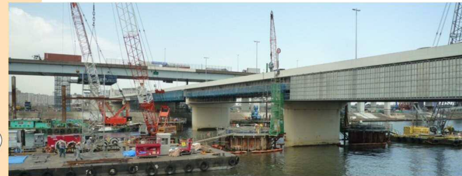
写真① 河川部基礎工事状況
