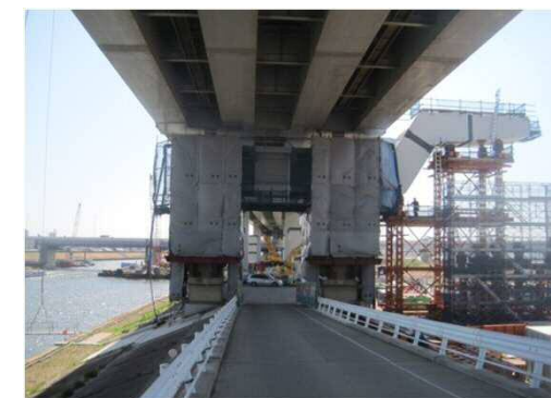
写真② 橋脚工事状況
