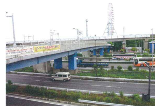
今年度点検を実施する臨海橋 (湾岸線葛西付近)
