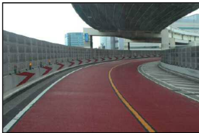
注意喚起カラー舗装
