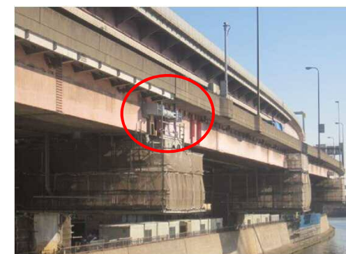
写真② 制震装置取付状況
