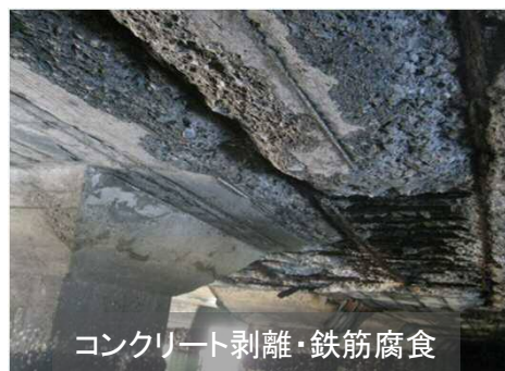
コンクリート床版の損傷
