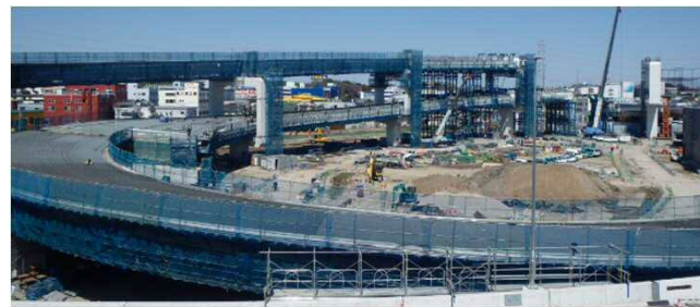
写真② 港北JCT (上部桁架設工)
