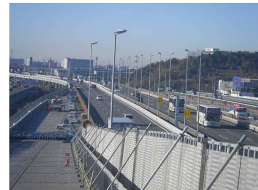
写真② Cランプ部 (上部工桁架設完了)
