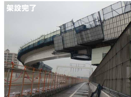
写真① 一括架設状況 (湾岸線横断面部)
