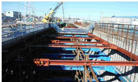
写真① 北西線発進立坑部 (立坑掘削工(市施工))
