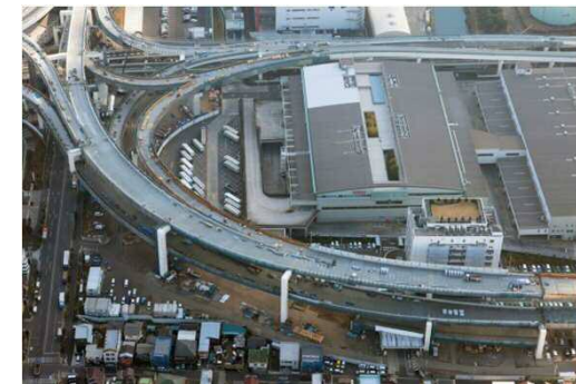
写真④ 北線生麦JCT (上部工、橋面工)
