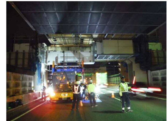
橋脚架設状況(夜間規制)
