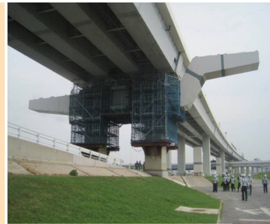
河川部 橋脚架設工
