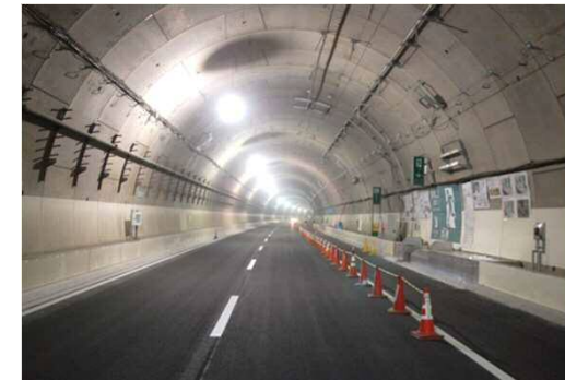
写真③ 北線トンネル内装工
