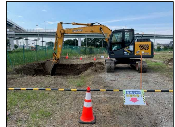
現場着手状況(与野JCT付近)
