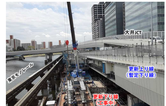
写真③ 東品川栈橋部 施工状況 (狭隘な空間での橋桁架設)
