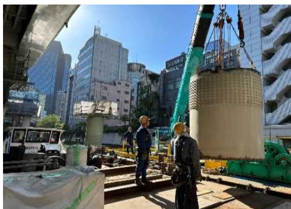
写真② 江戸橋出口 橋脚撤去状況
