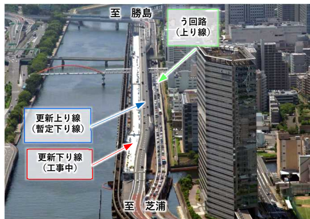
写真① 現場状況 (遠景)
