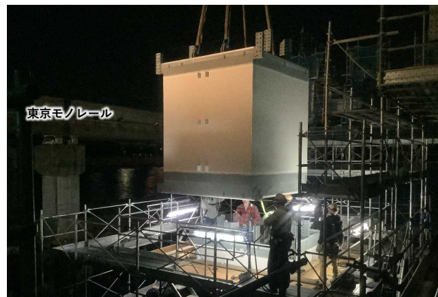
写真② 東品川栈橋部 施工状況 (橋脚設置)
