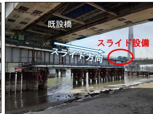
写真③ 既設橋のスライド設備設置状況
