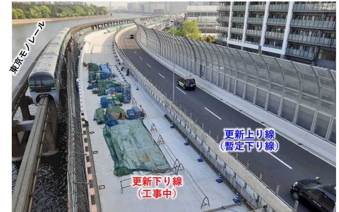
写真③ 鮫洲埋立部 施工状況 (プレキャストボックス設置、床版工が完了)
