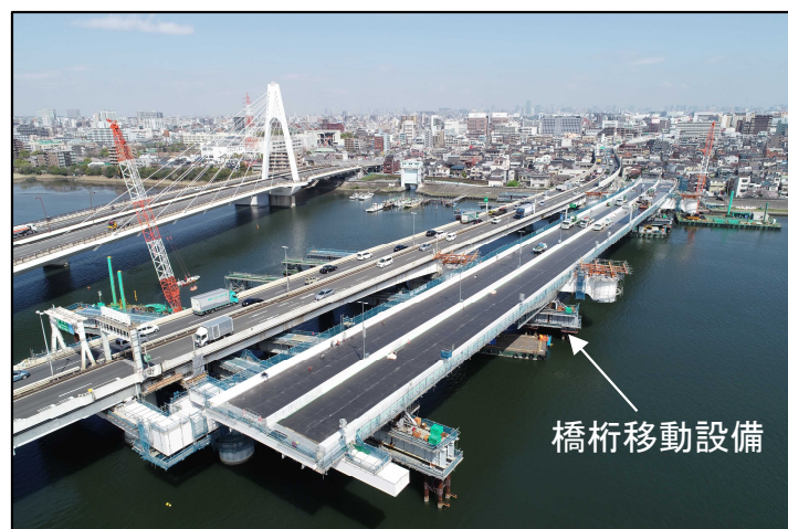
写真① 工事区間全景
