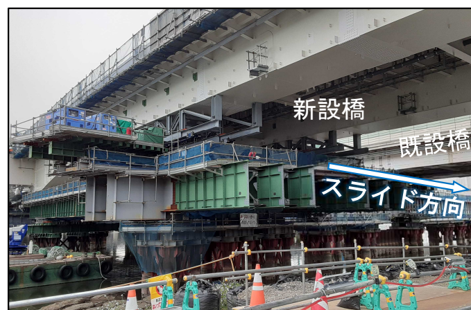
写真② 新設橋のスライド設備設置状況
