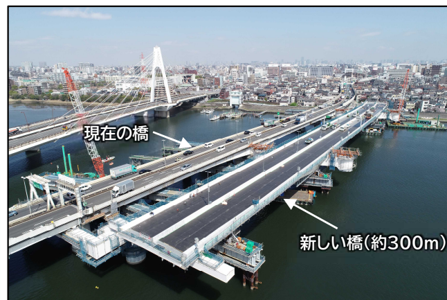
工事区間全景
