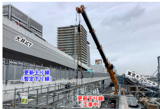
写真② 東品川栈橋部 施工状況 (狭隘な空間での橋桁架設)
