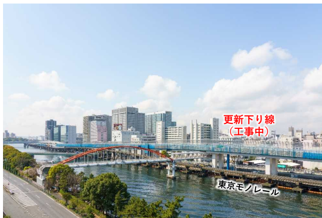
写真① 現場状況 (遠景)
