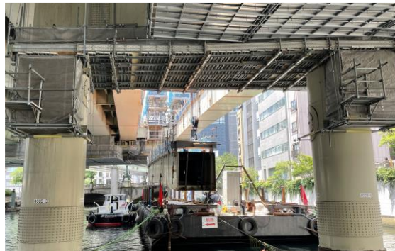
写真② 橋桁撤去状況(江戸橋出口)
