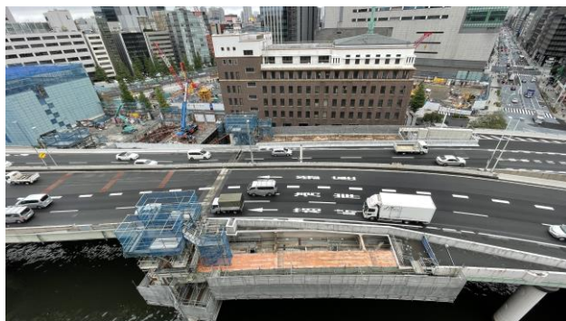
写真① 江戸橋出入口撤去工事状況
