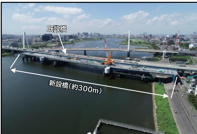
写真① 工事区間全景
