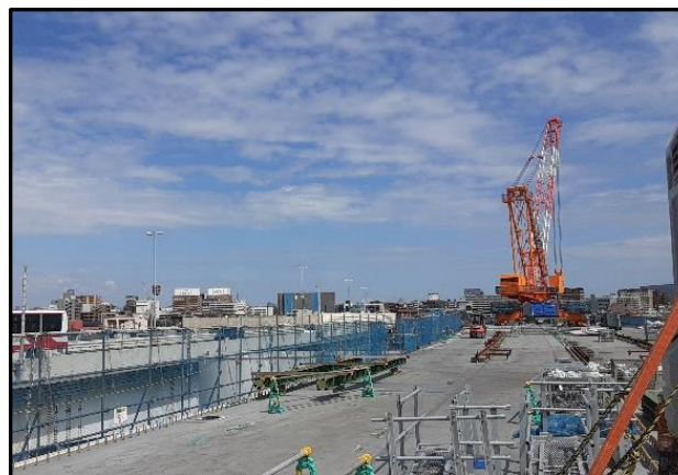
写真② 新設橋上の状況
