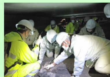
羽田トンネル現場視察の様子
