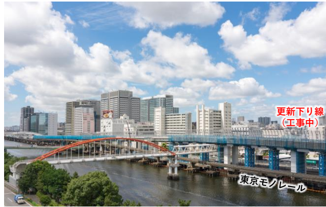
写真② 東品川栈橋部 施工状況 (橋脚工、橋桁架設工、床版工)
