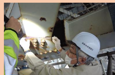
荒川湾岸橋現場視察の様子
