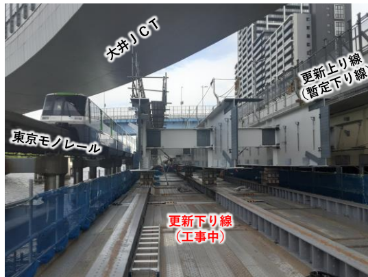
写真① 東品川栈橋部 現場状況 (大井JCT直下での橋桁架設)
