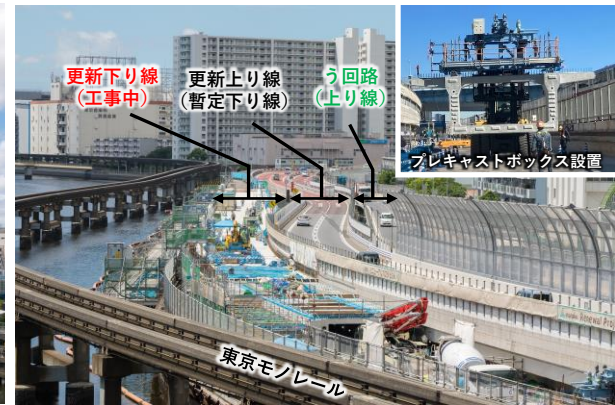
写真③ 鮫洲埋立部 施工状況 (プレキャストボックス設置・床版工)
