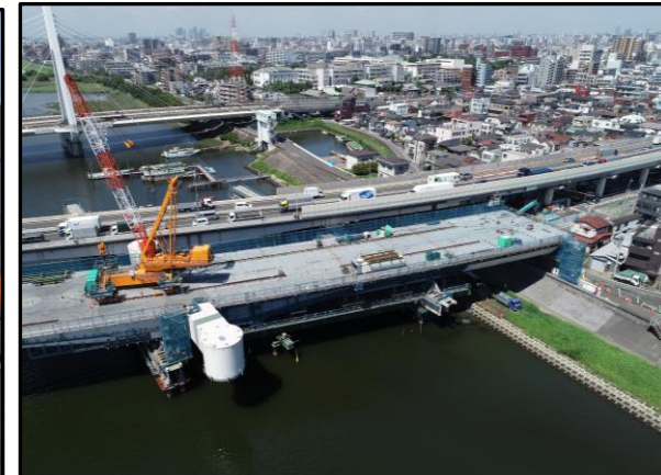
写真③ 大田区側径間 橋桁設置状況
