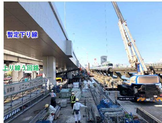
写真② 既設栈橋下部 撤去工
