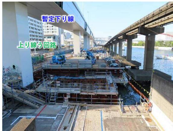
写真① 東品川栈橋部 橋脚基礎工
