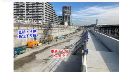
写真① 鮫洲埋立部 基礎コンクリート工
