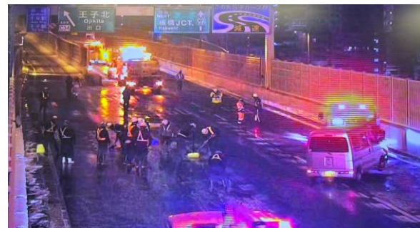
退出路確保のための砕氷作業(王子北出口付近)
