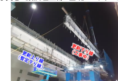
写真② 東品川栈橋部 桁架設工
