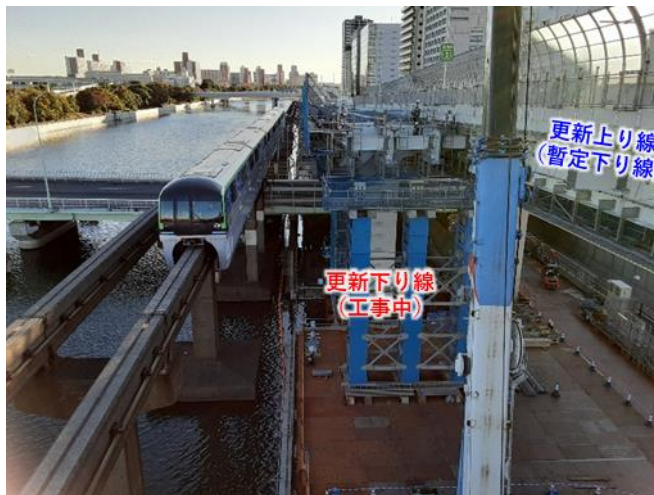
写真③ 東品川栈橋部 現場状況
