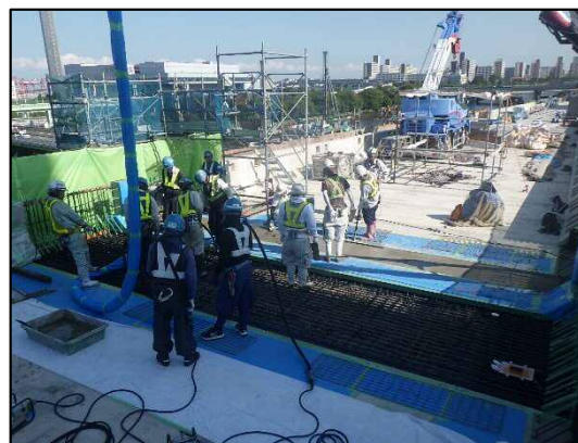
③東品川栈橋部(床版施工状況)
