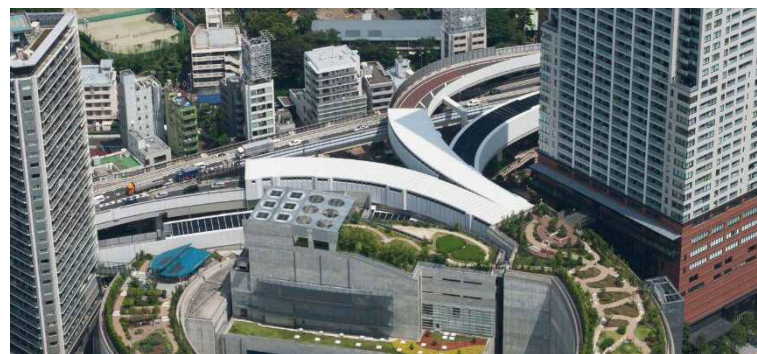
おおはし里の杜(大橋換気所)
