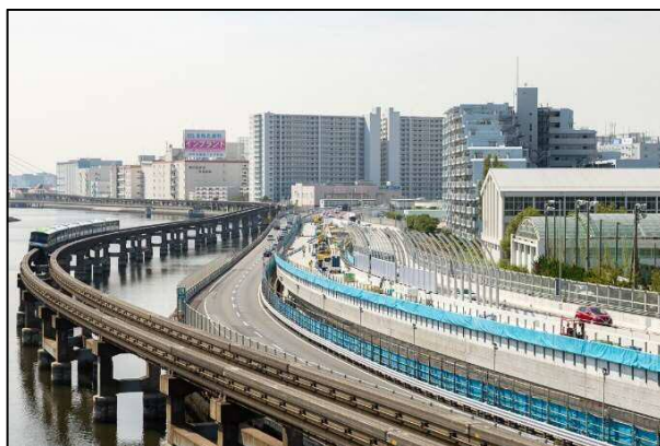
②鮫洲埋立部施工状況(全景)
