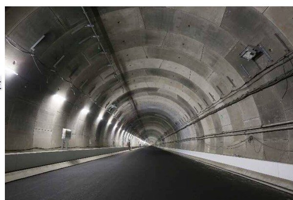
② トンネル部(舗装敷設状況)
