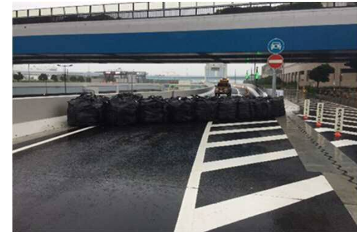
土のう設置状況(東京港トンネル付近)
