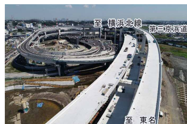
③ 横浜港北JCT部(全景)
