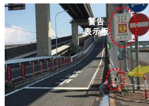
③ システム設置例 (千住新橋[外]出口)
