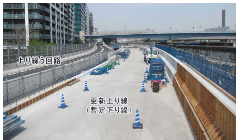
写真② 鮫洲埋立部 床版工状況
