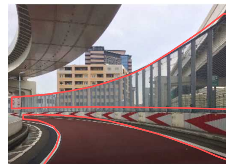
②フェンス設置・注意喚起カラー舗装 (二輪車安全対策／施設接触事故対策)
