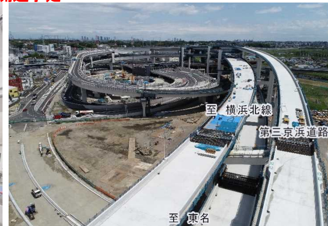
写真③ 横浜港北JCT部(桁架設状況)
