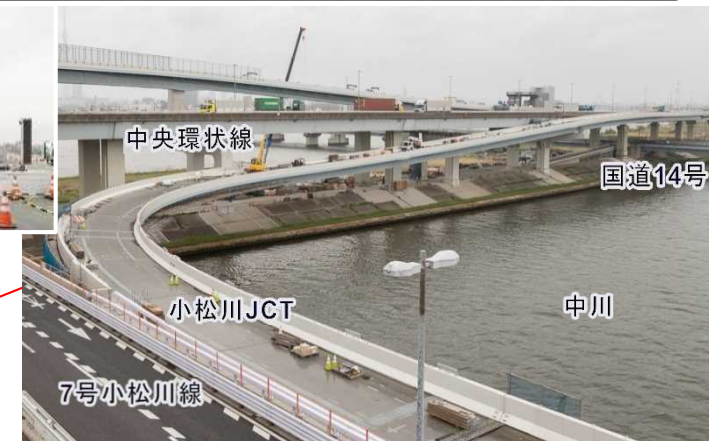
②小松川JCT 工事状況
