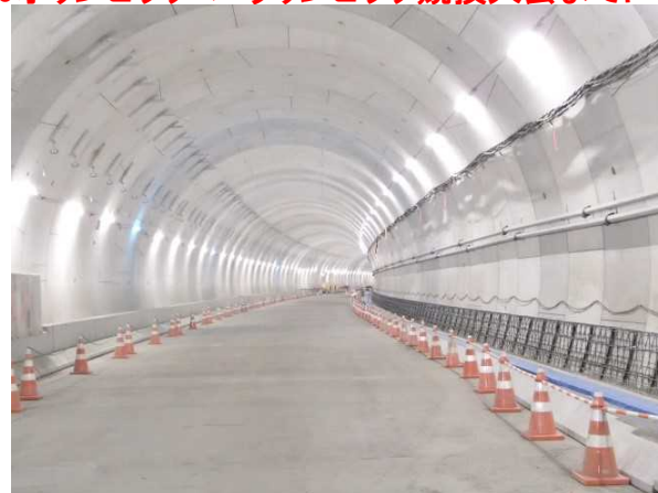
写真② トンネル部(内部構築工状況)
