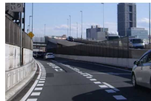
①舗装打換え・減速レーンマーク (施設接触事故対策)
