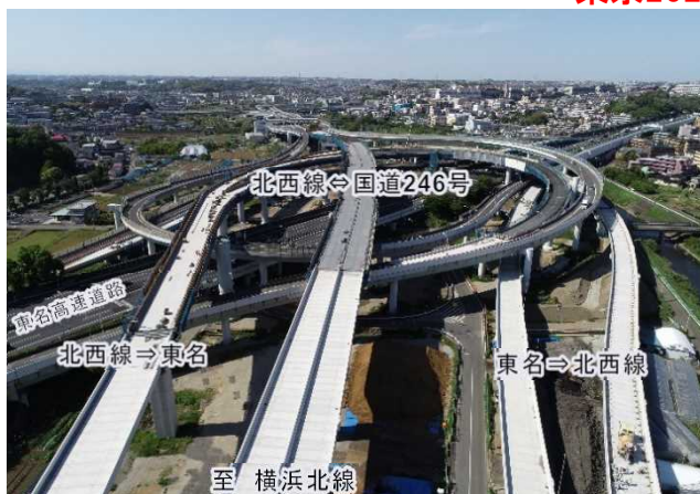
写真① 横浜青葉JCT部(桁架設状況)
