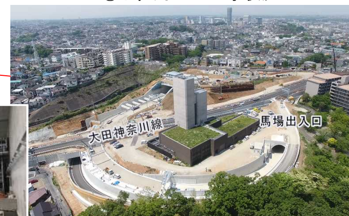
③横浜北線馬場出入口 工事状況
