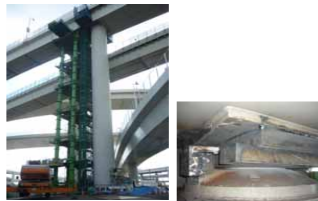
橋桁をベントで支持し、支承を補修
