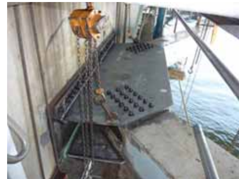
取付部材取替
