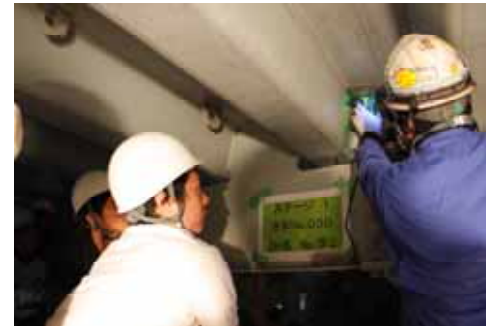
鋼構造物き裂補修デモ
