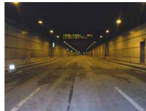
トンネル継目の漏水補修
