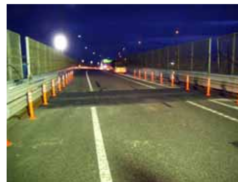
段差修正、舗装・ジョイント補修
