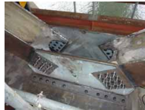
取付部材取替
