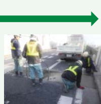
コンクリート打設
