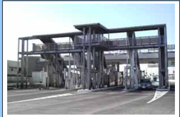
【写真】 用賀本線料金所における安全通路の整備
