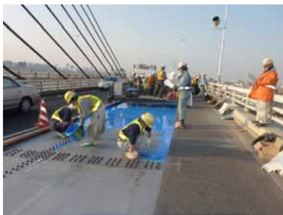
【中央環状線における休日 24 時間一車線規制工事の例】
