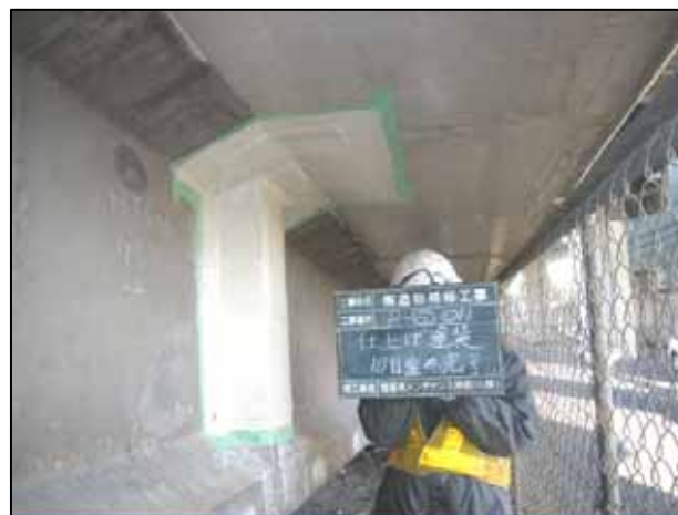
(施工後) 突出防止工事实施後
