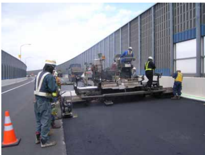
【舗装工事実施状況】
