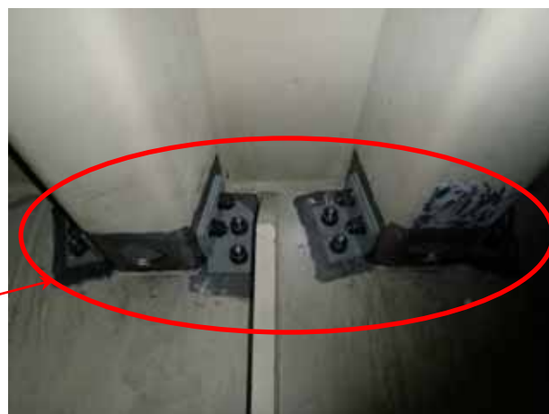
【湾岸線扇島付近における 鋼床版の当て板補強】
