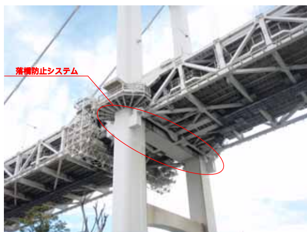
【レインボーブリッジの耐震補強】
