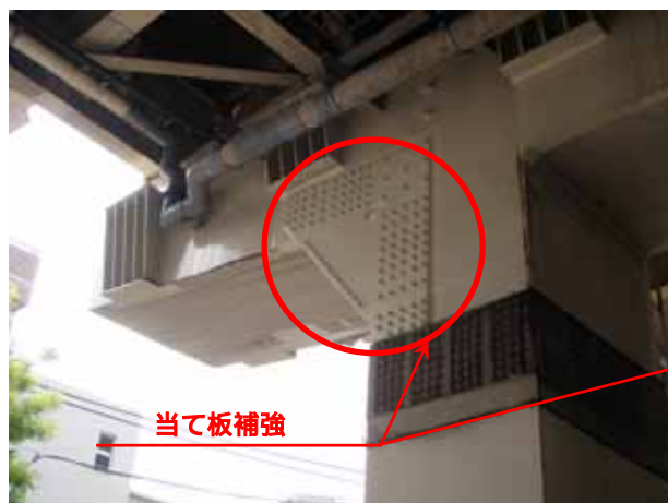
【9号深川線門前仲町付近における 鋼製橋脚隅角部の当て板補強】
