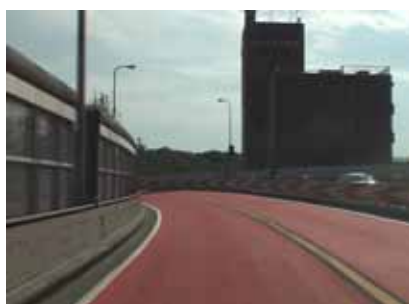
【注意喚起カラー舗装】
