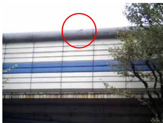
(4号新宿線千駄ヶ谷付近: 遮音壁の損傷)
