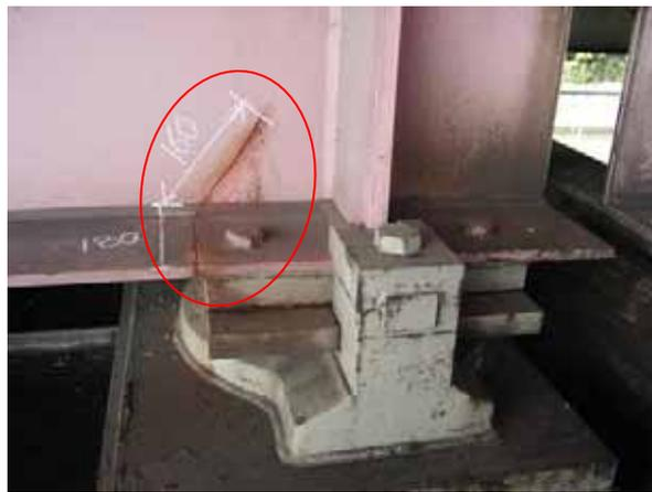
(中央環状線小菅付近: 鋼桁の亀裂)
