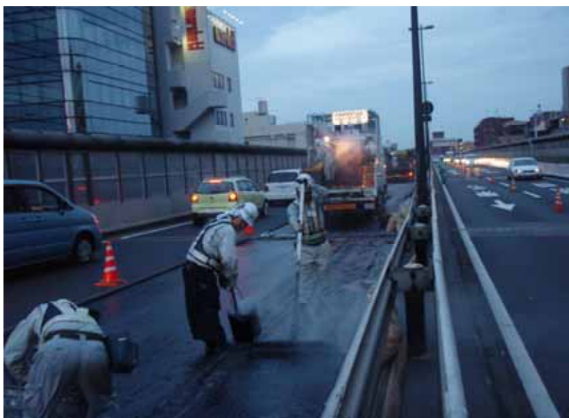
【舗装工事実施状況】
