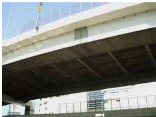
施工前（上層桁）
