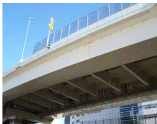
施工後（上層桁）
