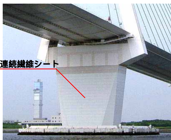
【鶴見つばさ橋の耐震補強（主塔基部のせん断補強）】
