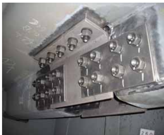
【 中央環状線四つ木付近の鋼床版の補強
