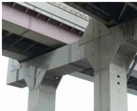
【中央環状線小菅付近の 鋼製橋脚隅角部における当て板補強】
