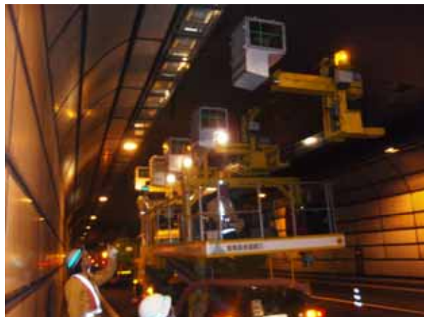
【水噴霧設備点検 (湾岸線空港北トンネル) 平成20年11月実施】
