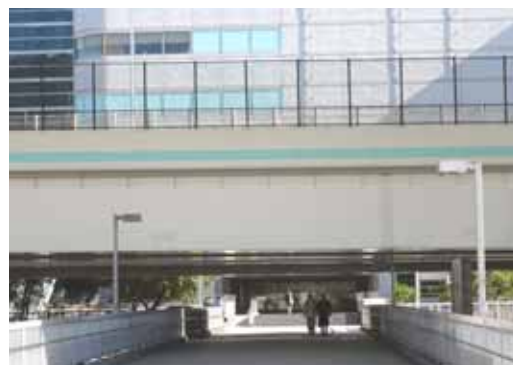
施工後（下層桁）
