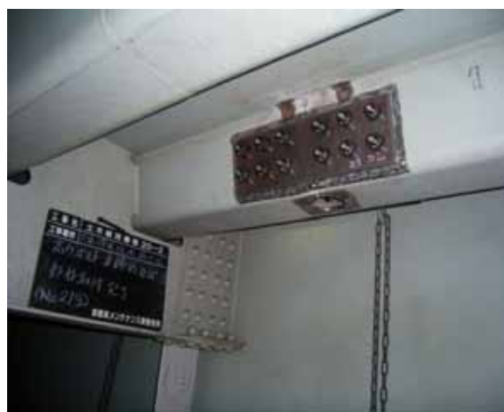
【 中央環状線四つ木付近の鋼床版の補強
