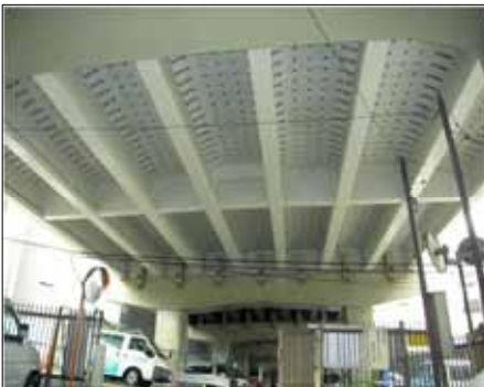
予防保全対策（繊維補強）
