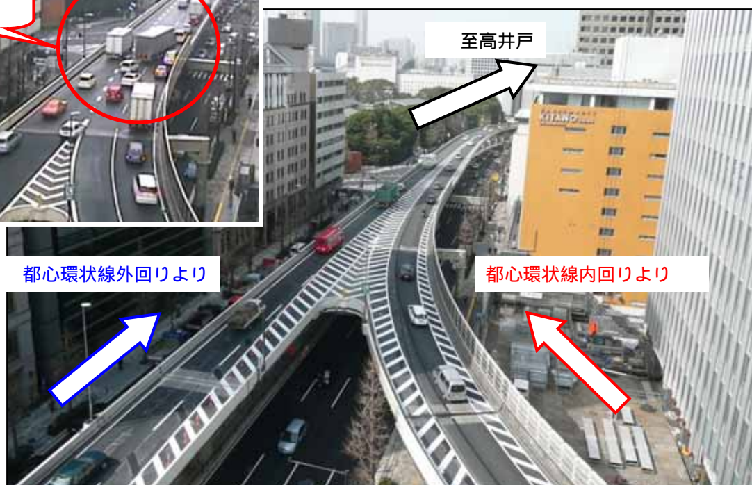
【合流部区画線の改良 4号下り三宅坂JCT合流部】
