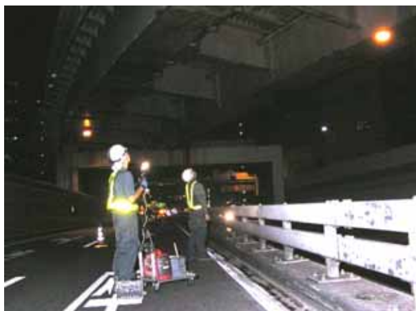
【高速道路上徒歩点検 (1号羽田線芝浦付近) 平成20年8月実施】
