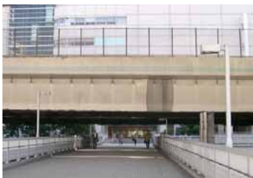
施工前（下層桁）
