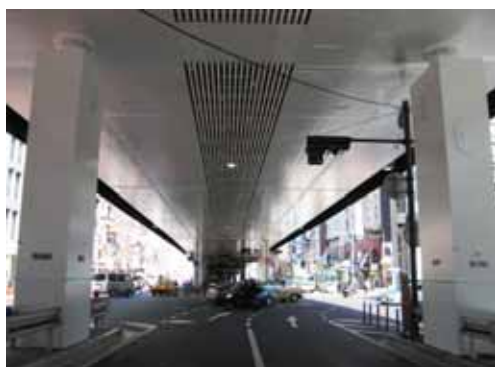
施工後（桁下、昼間）
