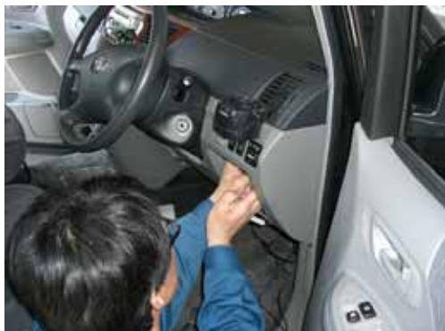
【ETC 車載器取付作業】
