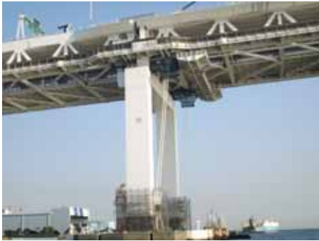
【横浜ベイブリッジの耐震補強：耐震対策の一つである桁の浮き上がり防止構造の設置】
