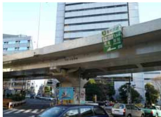
塗装補修後（遠景）
