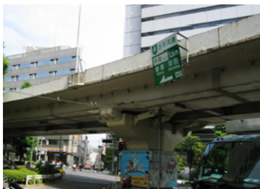
塗装補修前（遠景）
