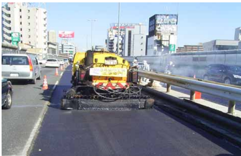
【舗装工事実施状況】
