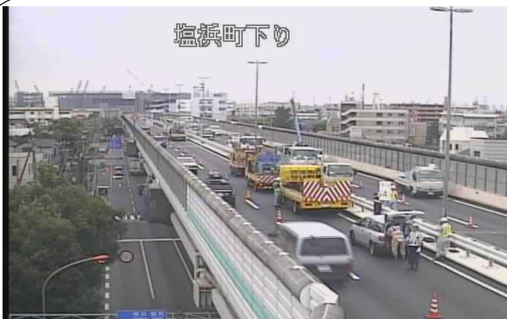
【1号横羽線における休日 24 時間集中工事の例】 (交通監視用テレビカメラによる写真)
