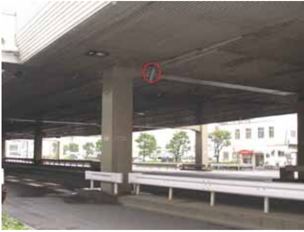
(1号羽田線浜崎橋付近)
