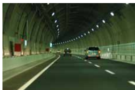
開通後の状況写真
